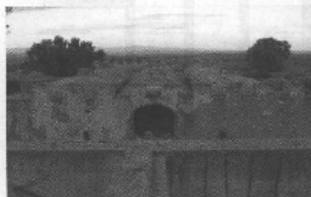
Fig. 7 : La rampe d'accès (vue de derrière).
