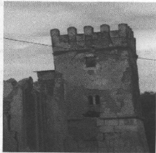
Fig. 3 : La tour nord avec ses deux niveaux séparés par une moulure en boudin.
